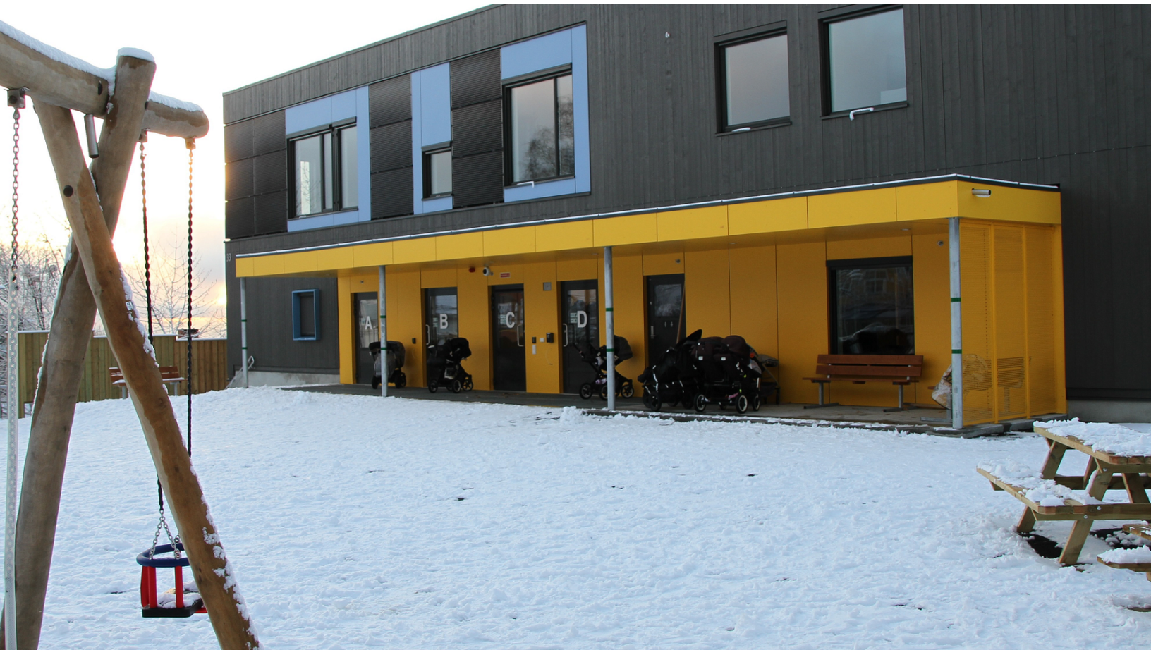
Bråtenalleen barnehage er en av de første plussusbarnehagene i Oslo. Foto Omsorgsbygg
