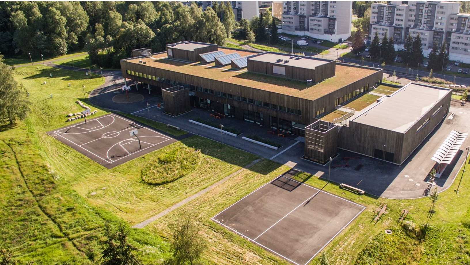
Granstangen skole ligger i grøntdraget Grandsdalen mellom Furuset og Høybråten. Foto Backe Prosjekt AS
