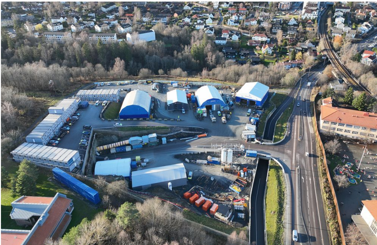
De forberedende arbeidene inkluderte bygging av 9,2 km tunneler samt åtte nye haller og fire sjakter. Foto: Skanska
