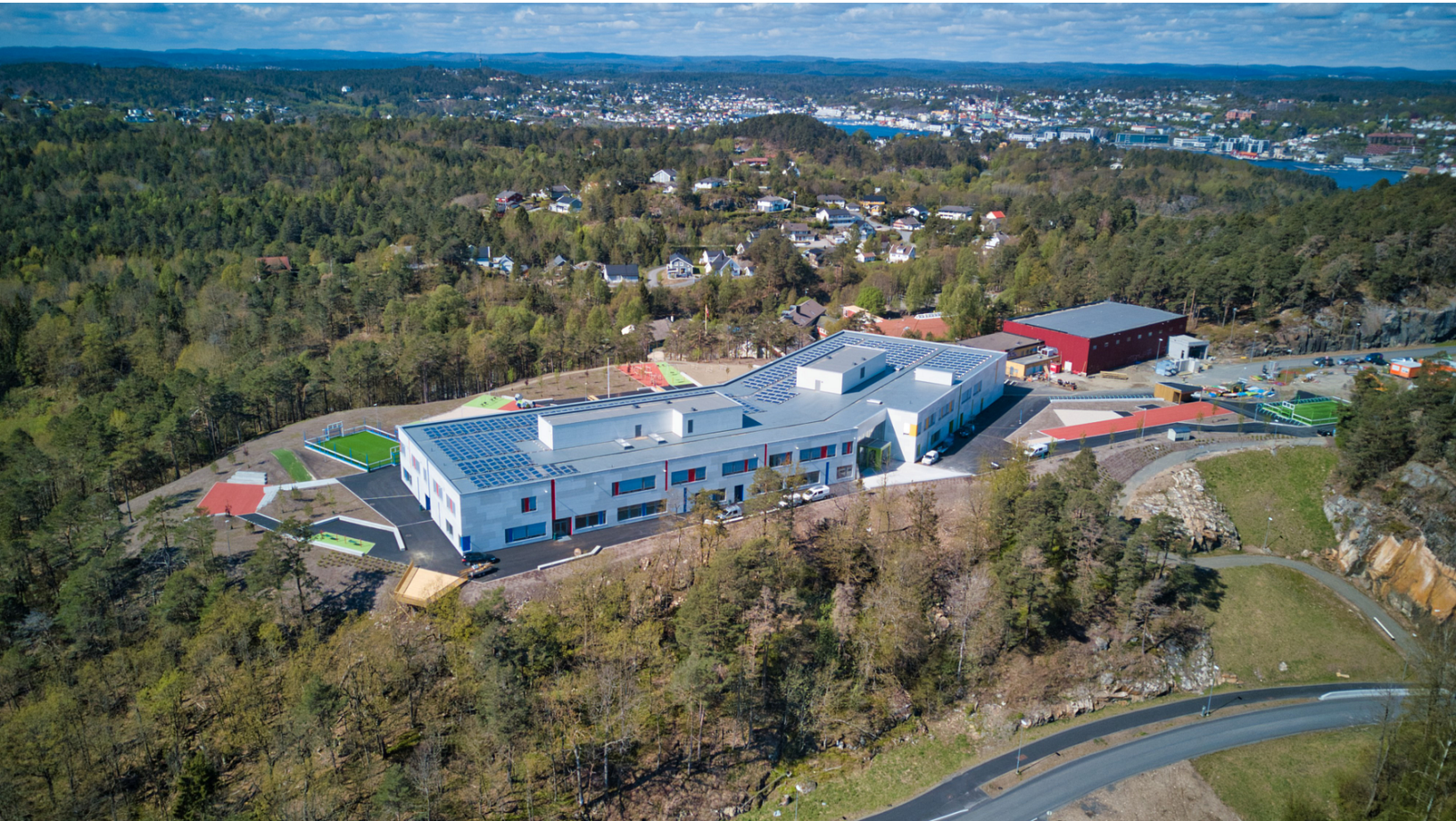
Roligheden skole ligger på Tromøy i Arendal kommune. Foto: Arendal Eiendom KF
