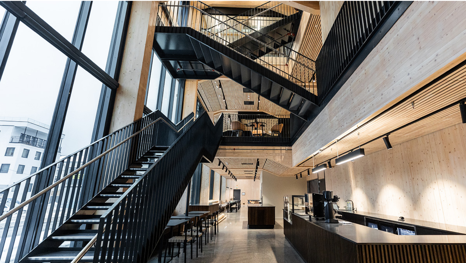
SporX i Drammen er et 40 meter høyt kontorbygg som er bygget av rent tre. Foto: NYG
