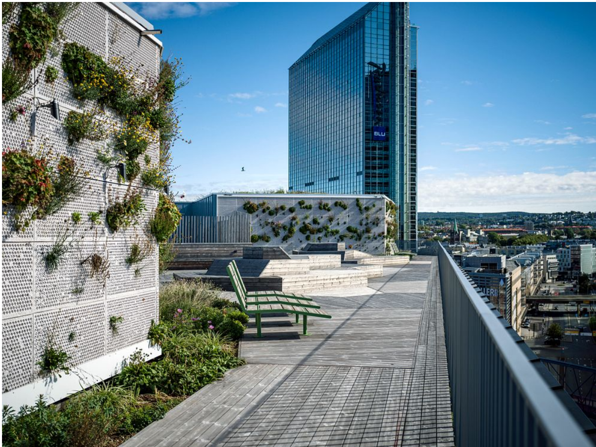
Den grønne veggen og det blågrønne taket bidrar til økt naturmangfold, redusert energibruk og ikke minst overvannshåndtering. Foto: Knut Neerland
