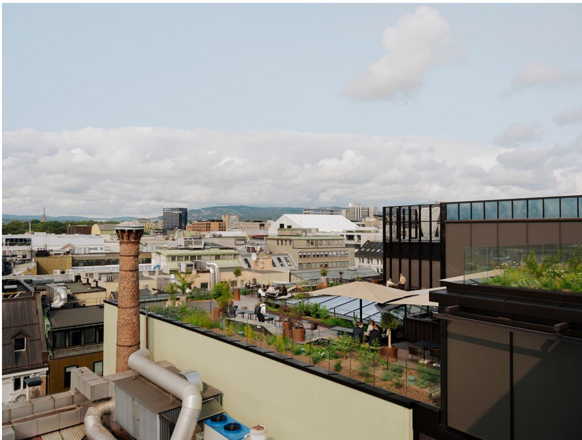
Til sammen er det etablert 1300 kvadratmeter med plantefelt på takflatene. Foto: Einar Aslaksen
