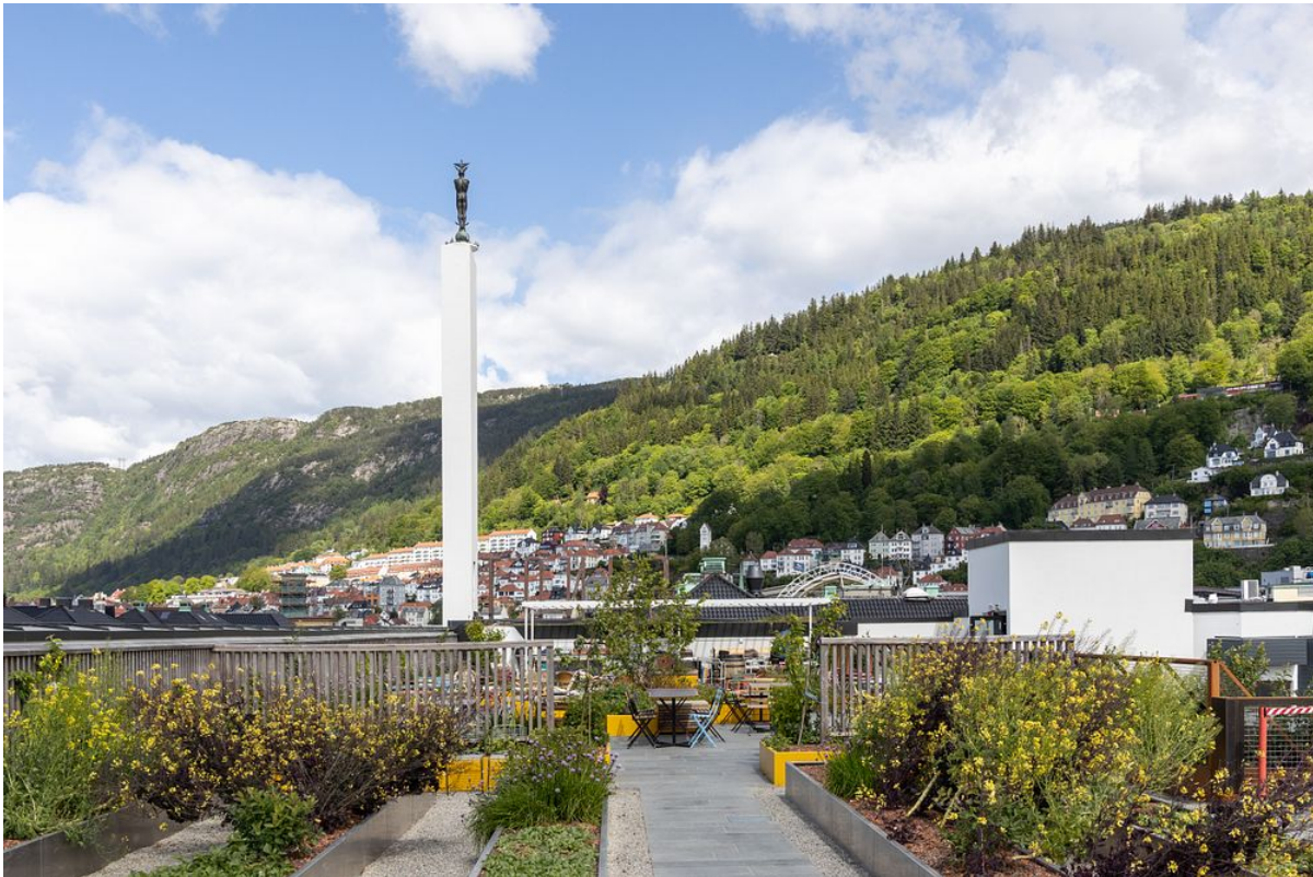
Mattak har forvandlet en grå takflate til et grønt oppholdsrom med spiselige vekster. Foto: Luminare Eirin Helland
