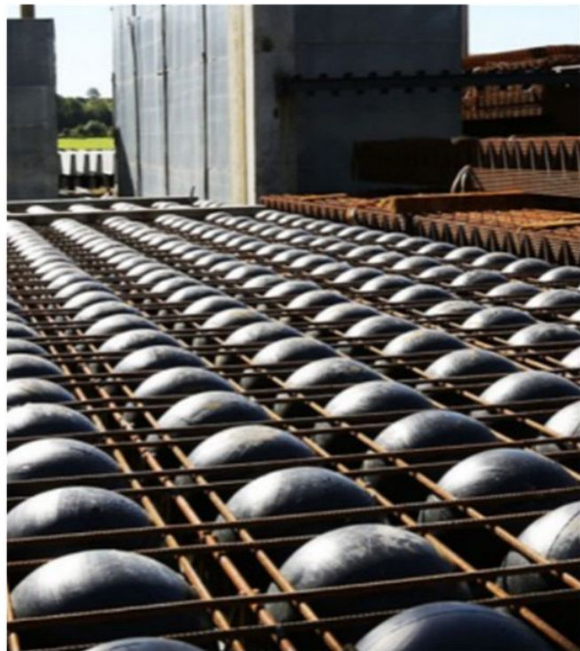
Det ble benyttet bobledekker i prosjektet. Foto: DNB Næringseiendom
