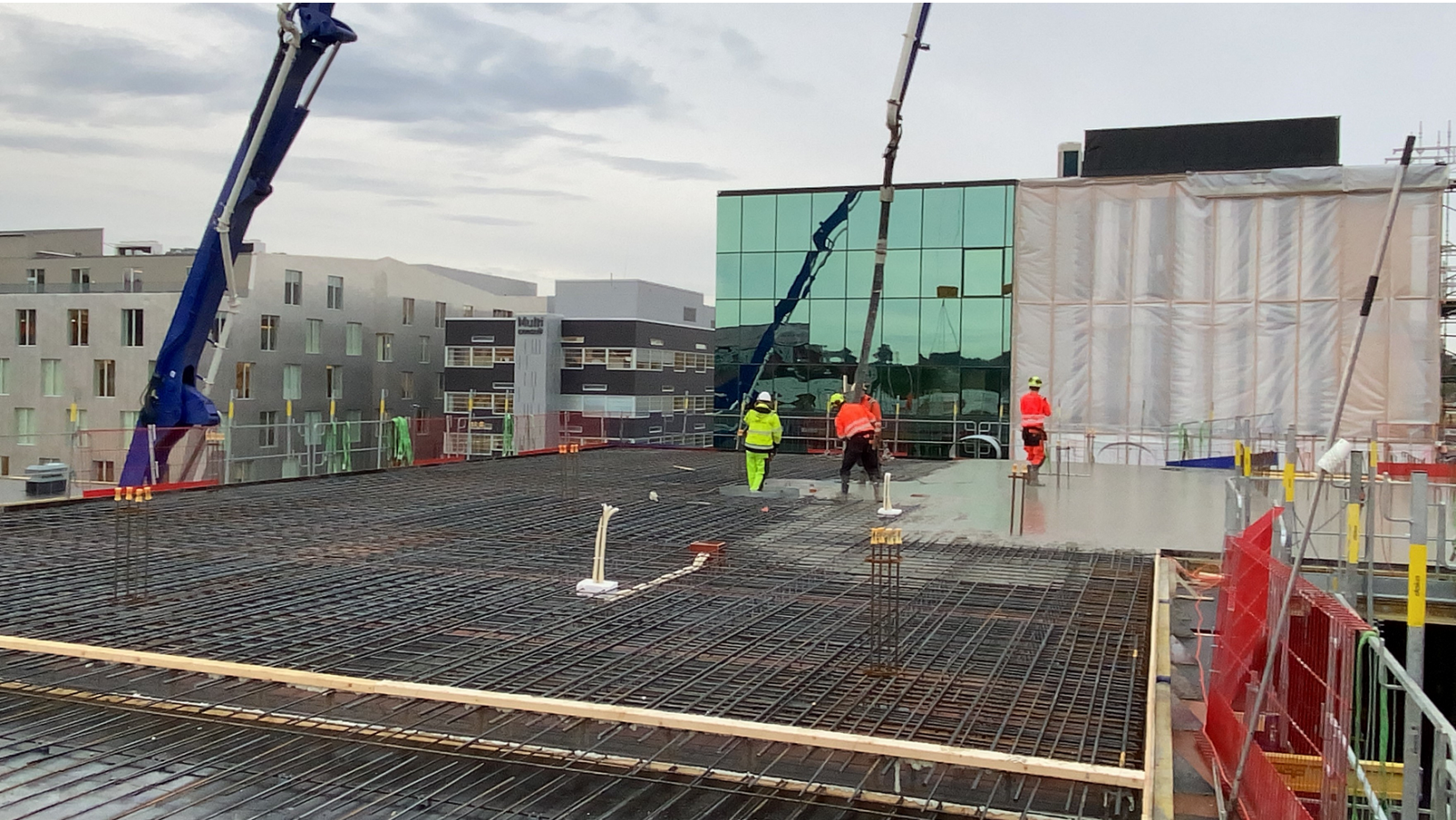
Støp med ekstremlavkarbonbetong på ALO-bygget i Trondheim. Foto: R. Kjeldsberg AS Eiendomsutvikling
