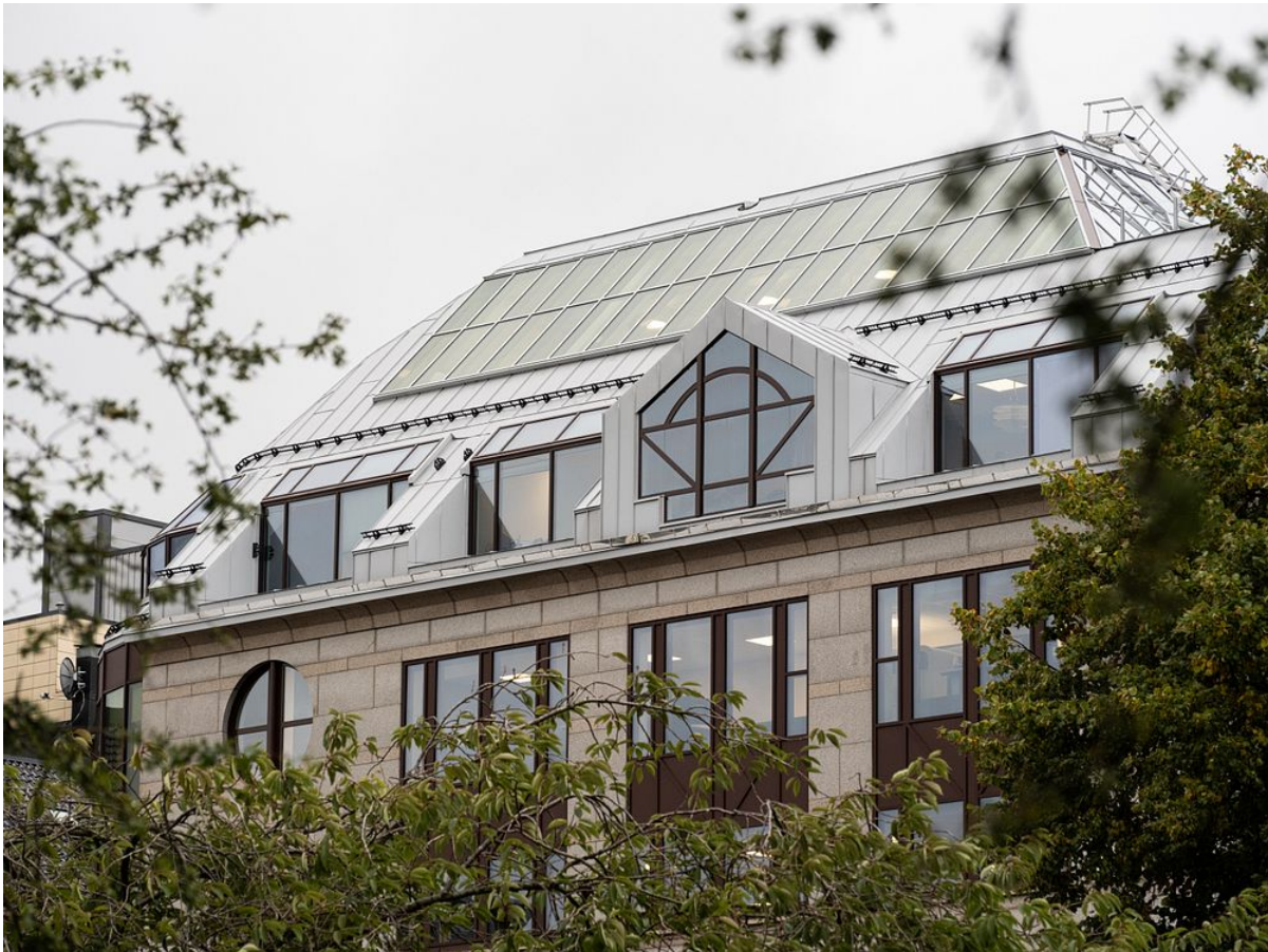
Bygget har fått elektrokromatiske glass i takvinduer og enkelte steder i fasaden. Foto: Kyrre Sundal/Mad Arkitekter
