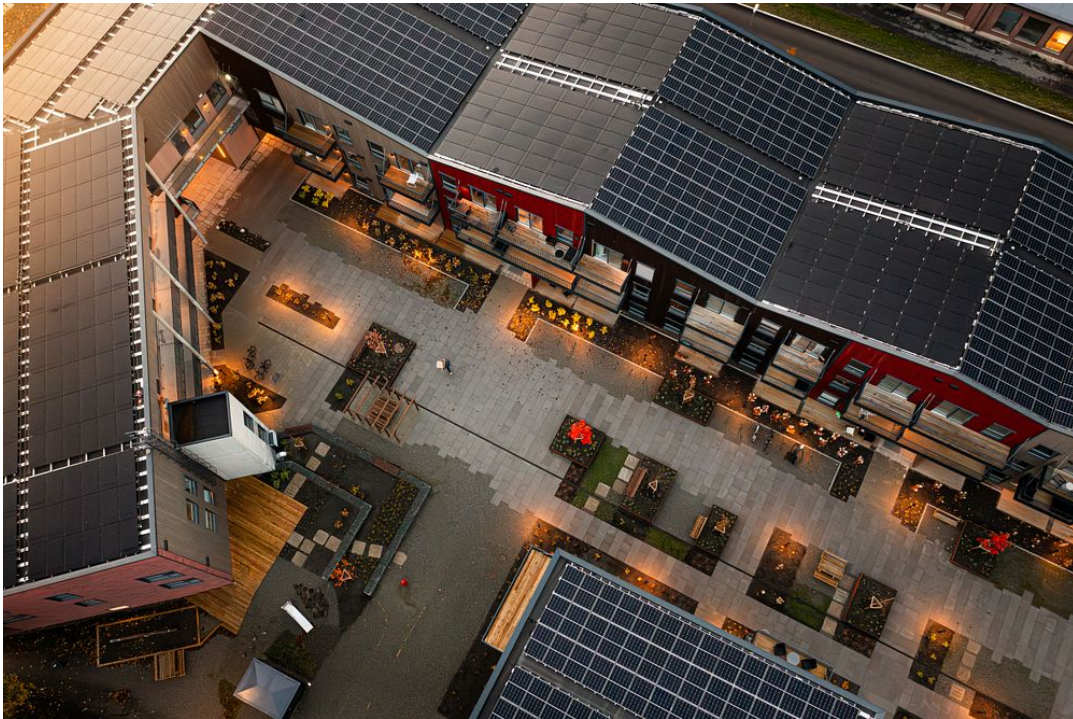
Ved hjelp av geotermiske energibrønner og solceller, sikrer Gartnersletta ren, lokalprodusert energi.
