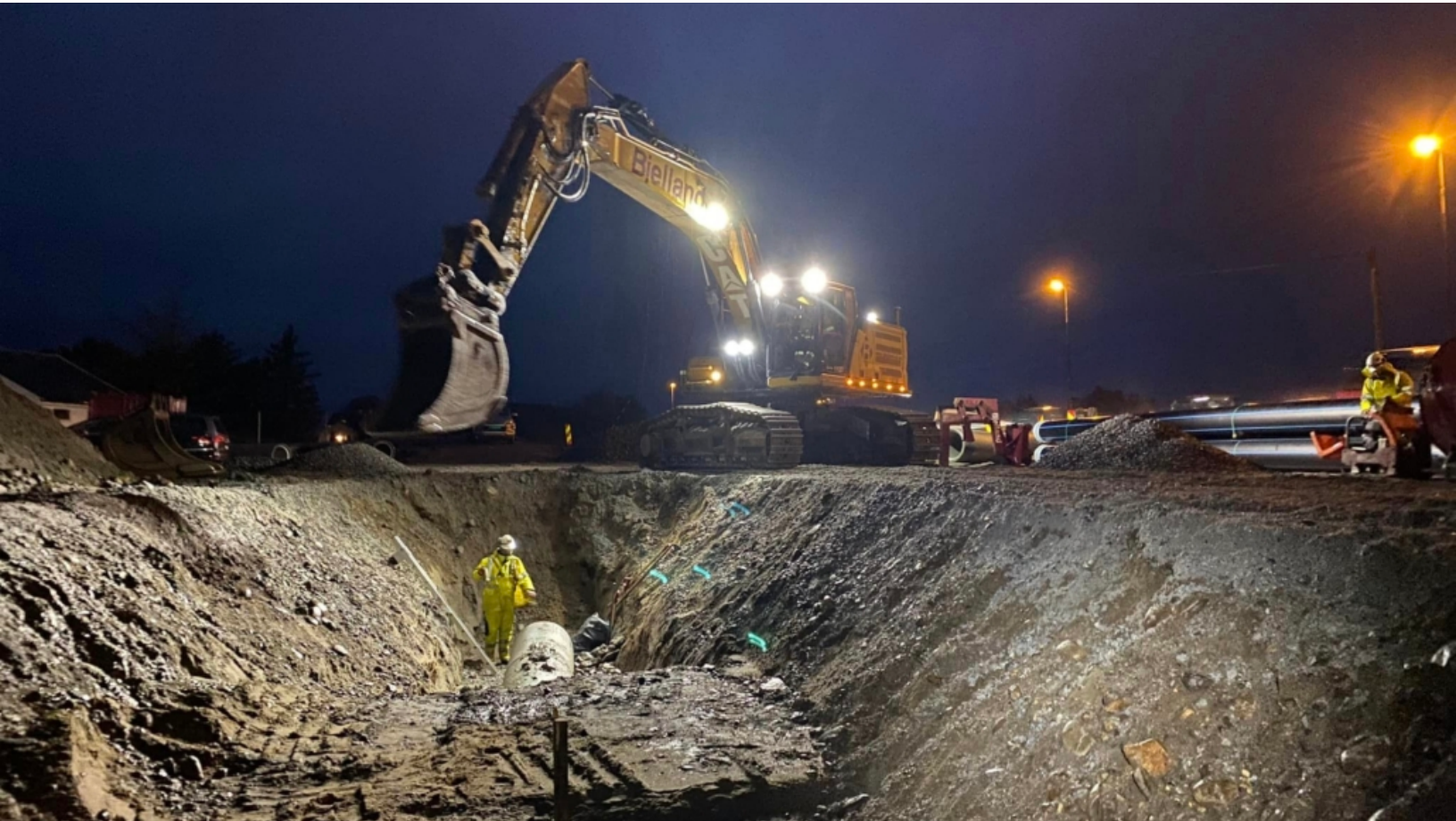
En av Bjellands elektriske 25-tonns gravemaskiner i sving. Foto: Bjelland AS
